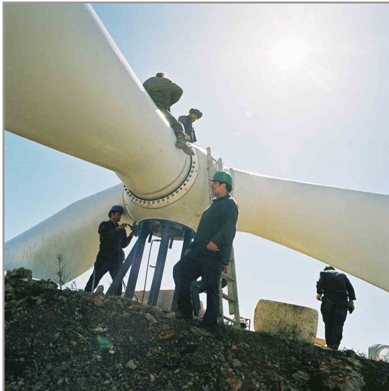
Chantier de parc éolien (ici à Néviau, dans l'Aude) (photo : Djamel Dine Zitout)
