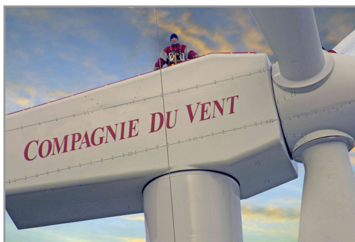
Technicien sur une nacelle d'éolienne à Brem-sur-Mer (photo : Pierre Lamy-Rousseau)
